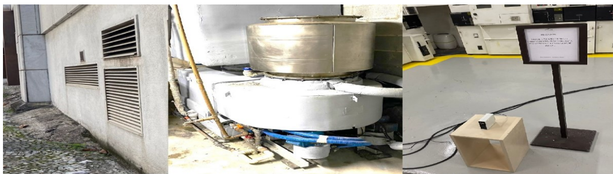
Figura 7. Cenário TAE- precipitador hidrodinâmico refrigerado ambiente interno.
