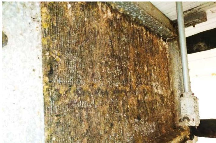
Figura 1. Evaporador obstruído por sujidades e microrganismos
