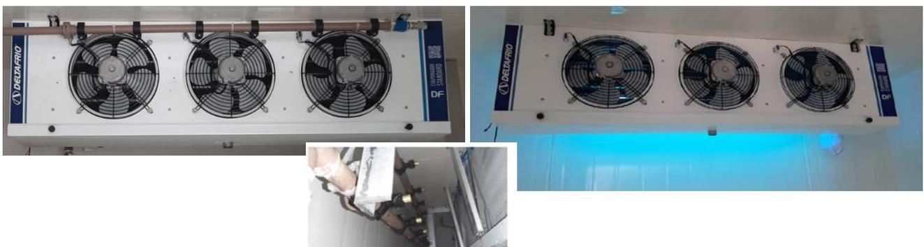
Figura 7. Evaporador Deltafrio protótipo montado com os sistemas SHA e SHU
