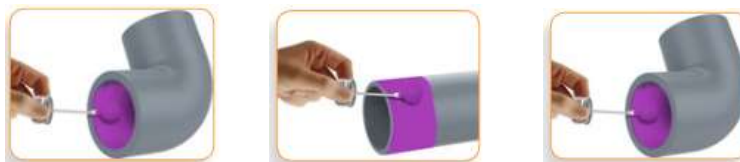
Passar primer no tubo e conexão
