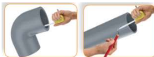
Marcar profundidade da bolsa no tubo
