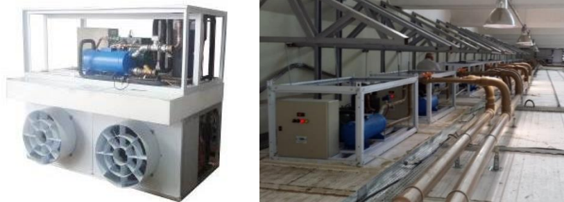
Figura 4. Monoblocos frigoríficos de teto com condensação a água Termoprol Zanotti
