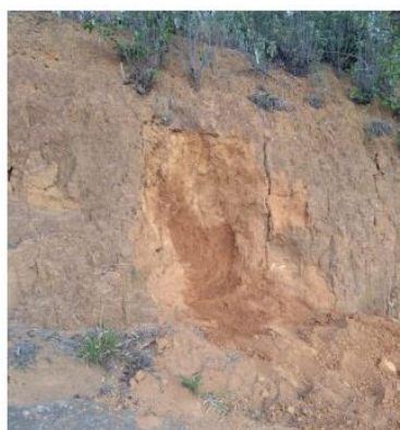
Figura 1. Talude da PROINFRA (Fonte: MELO, 2020)
