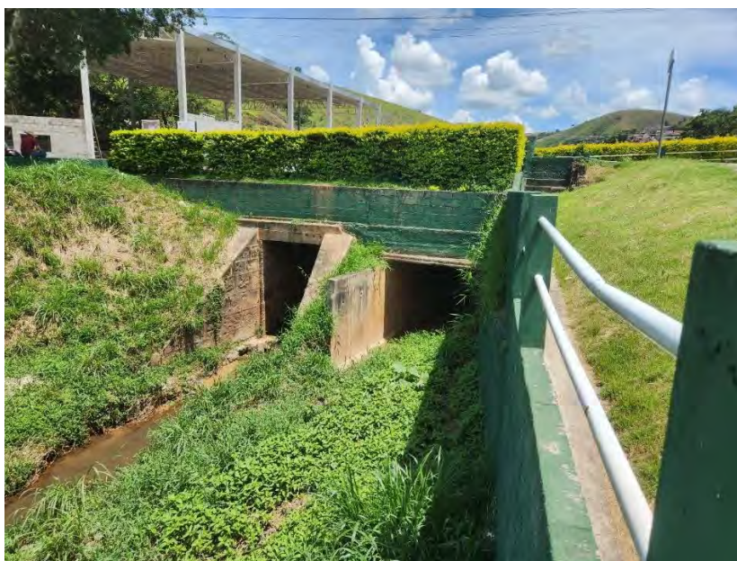
Figura 7. A duplicação da vazão da ponte 2 sobre o córrego da Laranjeira não garantiu a solução das inundações em Paraibuna. Foto: Anália Amorim, 2023.
