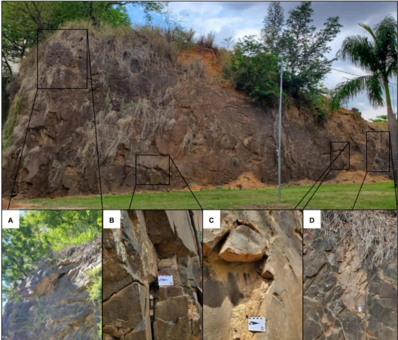
Figura 4. Talude 2, de 37,20 metros de comprimento e aproximadamente 10 metros de altura, com fatores considerados de risco evidenciados para escolha como objeto de estudo. Zona extremamente fraturada com blocos suspensos no alto do talude (A). Fraturas seguindo a inclusão de fluido magmático diferencial (B). Bloco solto com dimensão métrica em altura e local acessível ao público (C). Cicatriz de movimentos recentes de massa (D).
