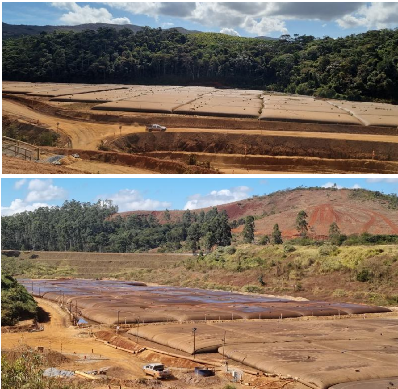
Figura 6: Registro fotográfico dos tubos em operação.
