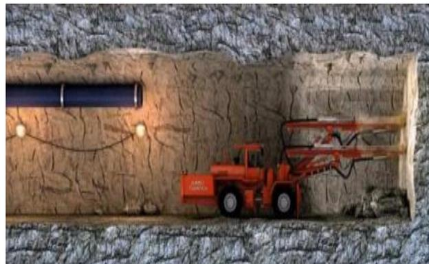
Figura 4. Perfuração de um túnel com o emprego de uma perfuratriz hidráulica de lanças. Fonte: Vieira (2003)
