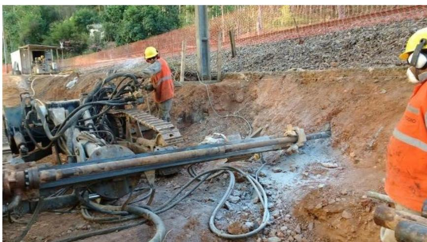
Figura 5 – Perfuratriz sobre esteiras realizando perfuração em plataforma ferroviária para instalação de tirantes. Fonte: Autor.
