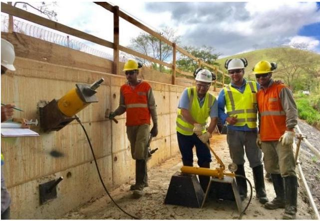
Figura 7 - Protensão realizada com Macaco Hidráulico e Bomba Manual. Fonte: Autor.
