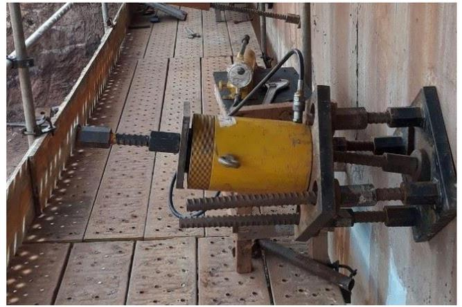
Figura 8 - Equipamento de Protensão com Macaco Hidráulico e Bomba. Fonte: Autor.
