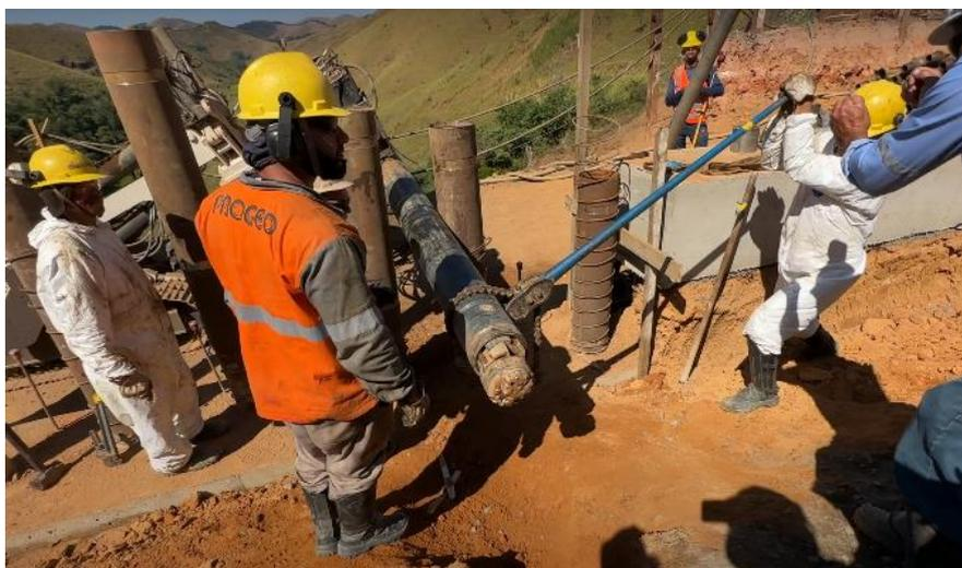
Figura 4 – Perfuração com sistema Odex, utilizando revestimento para evitar o fechamento do furo. Fonte: Autor.
