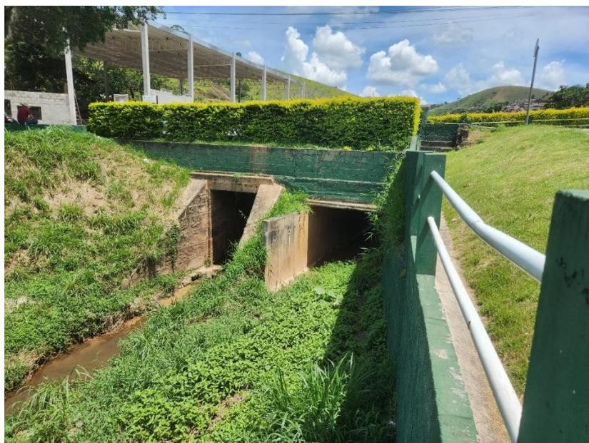
Figura 7. A duplicação da vazão da ponte 2 sobre o córrego da Laranjeira não garantiu a solução das inundações em Paraibuma. Foto: Anália Amorim, 2023.
