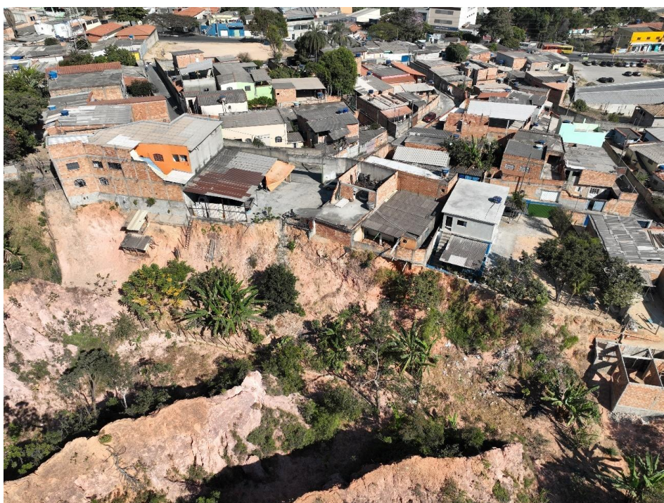
Figura 5 – Vista oblíqua dos setores de risco geológico na Regional Vargem das Flores, evidenciando seis residências posicionadas à beira da escarpa íngreme de uma voçoroca ativa. Fonte: Voo com VANT (imagem oblíqua), realizado em 20 de setembro de 2024.
