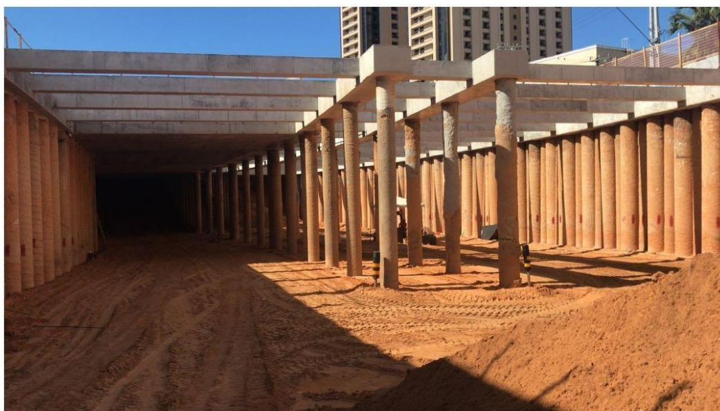
Figura 7: Cota de Projeto atingida na seção Sul da trincheira.
