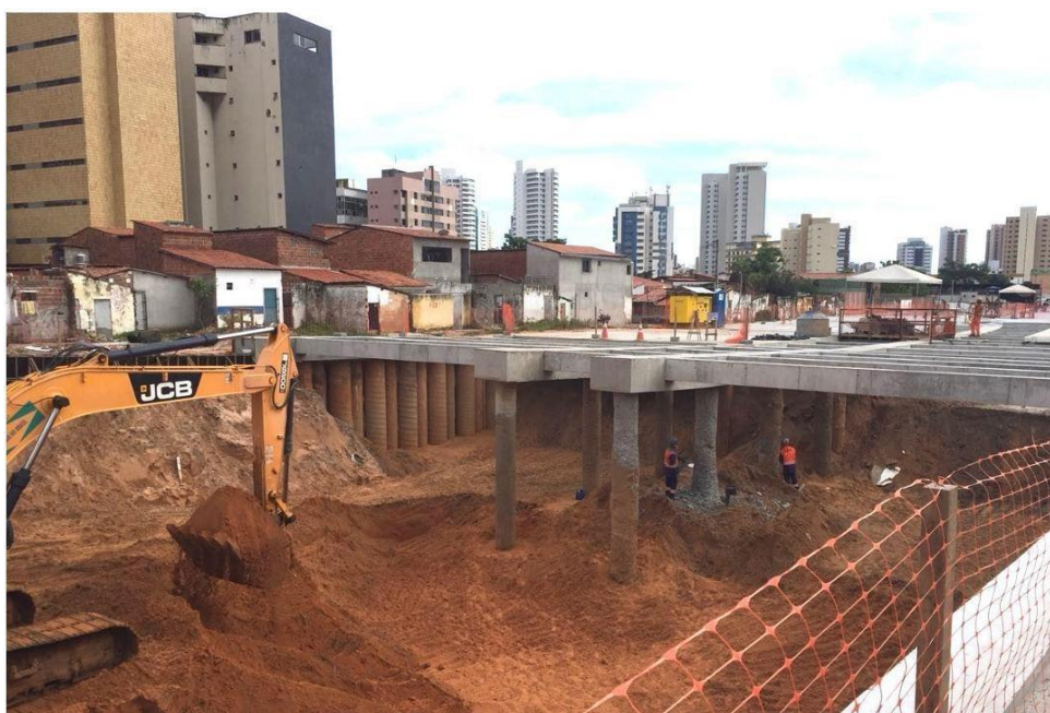
Figura 6: Estrutura do túnel executada e serviços de escavação iniciados.
