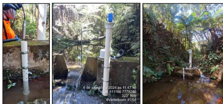
Figura 5. Instalação do sistema de monitoramento via satélite de vazão em vertedouros.
