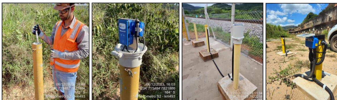
Figura 4. Instalação do sistema de monitoramento via satélite de Piezômetros e INAs.
