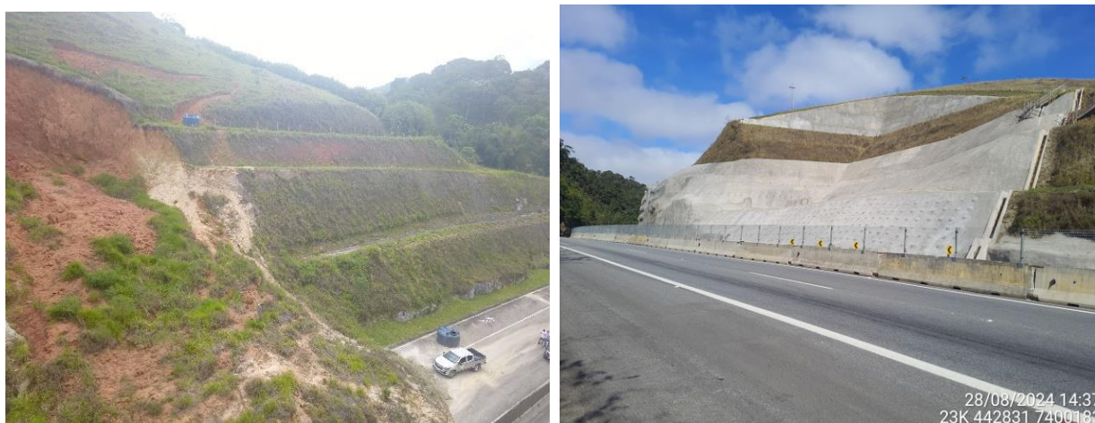
Figura 1. Exemplo de talude no Km 52+400 antes e após as intervenções propostas (Hidrossemeadura com biomanta e projeção de concreto).
