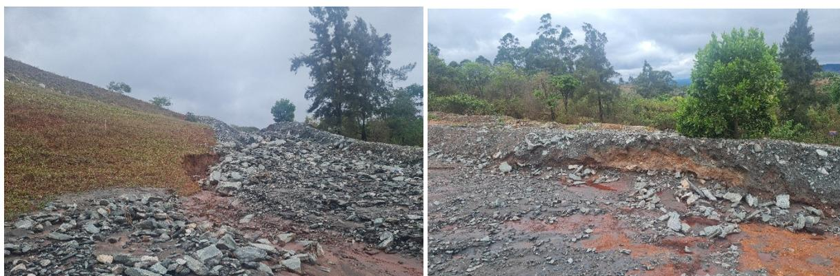
Figura 3 – Erosões no canal enrocado que direciona água para um canal periférico.
