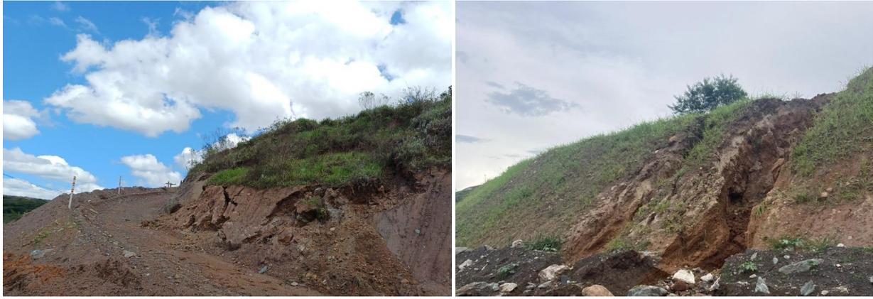
Figura 5 – Movimentação de massa e erosões pontuais.
