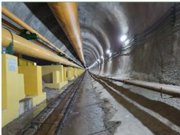
Figura 1. Trecho NATM (fonte: ALTA Geotecnia, 2023).
