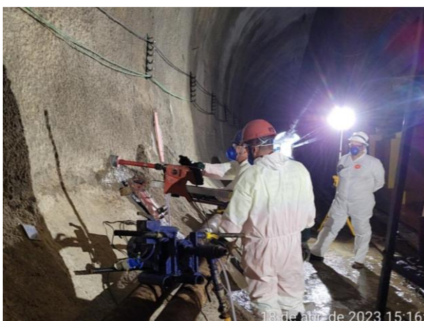
Figura 14. Execução de DHPs no trecho NATM (fonte: ALTA Geotecnia, 2023).
