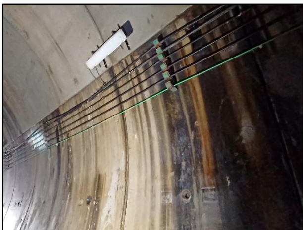
Figura 16. Trecho onde foram realizadas injeções e as infiltrações cessaram (fonte: ALTA Geotecnia, 2024).
