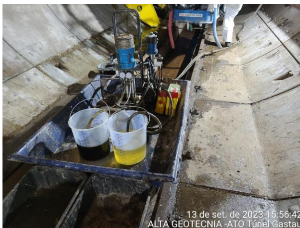
Figura 13. Sistema de injeção bicomponente utilizado no trecho em TBM (fonte: ALTA Geotecnia, 2023).
