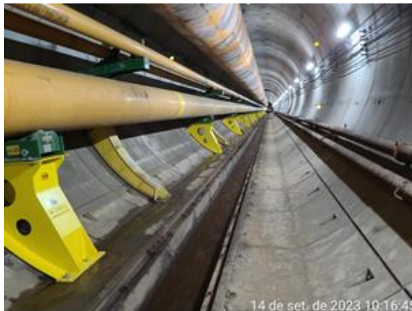
Figura 2. Trecho TBM (fonte: ALTA Geotecnia, 2023).
