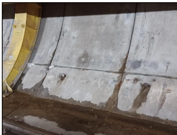
Figura 17. Trecho onde foram realizadas injeções e houve redução das infiltrações (fonte: ALTA Geotecnia, 2024).
