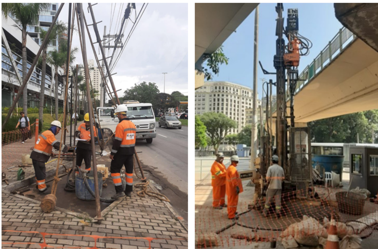
Figura 4 – Execução de sondagem a percussão manual (esquerda) e mecanizada (direita) em diferentes contextos urbanos da Linha 19-Celeste.
