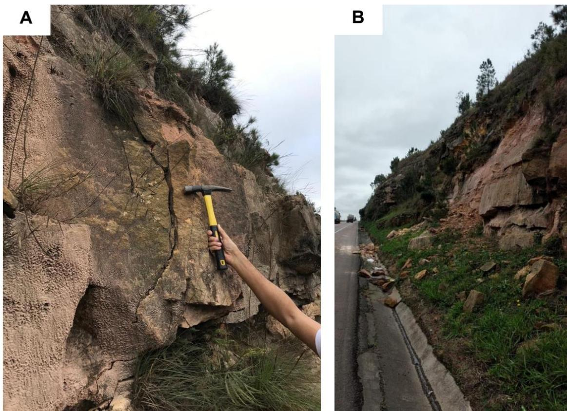
Figura 3. (A) Fraturas de caráter aberto, rugoso a liso, curvilíneo e irregular. (B) Planos regularmente densos, subparalelos a paralelos entre si e sub-horizontais.
