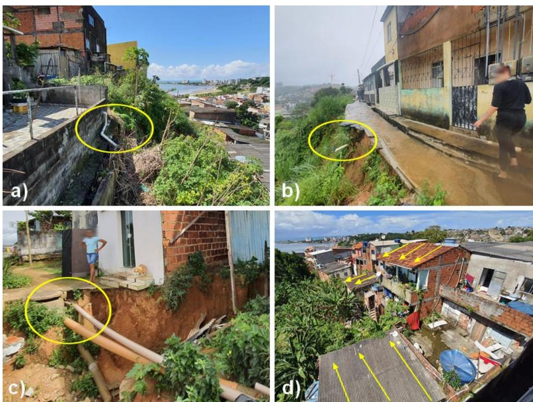
Figura 1: Evidências de direcionamento de águas na encosta.
