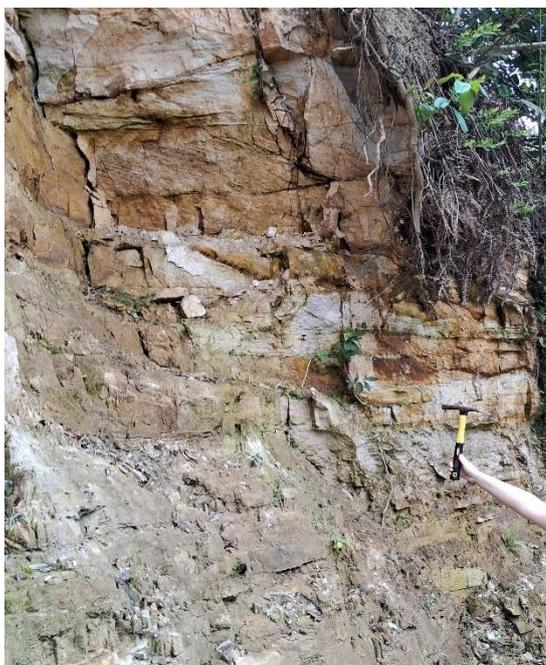
Figura 2. Vista parcial do talude de corte, evidenciando rochas intemperizadas e um conjunto de fraturas de diferentes orientações e intensidades.
