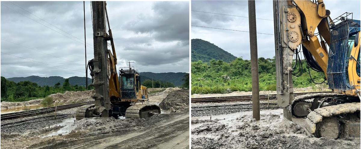
Figura 3 – Equipamento de Execução do DSM. Fonte: Elaborado pelos autores.
