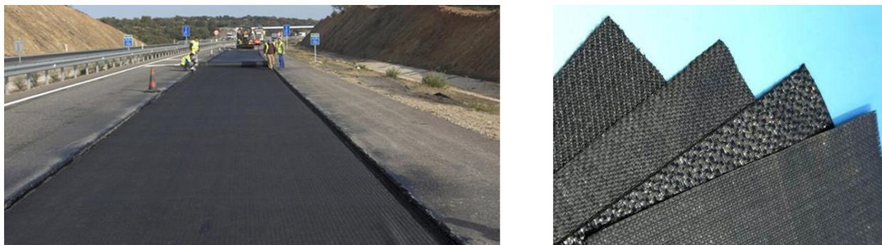
(a) Geotêxtil na pavimentação
