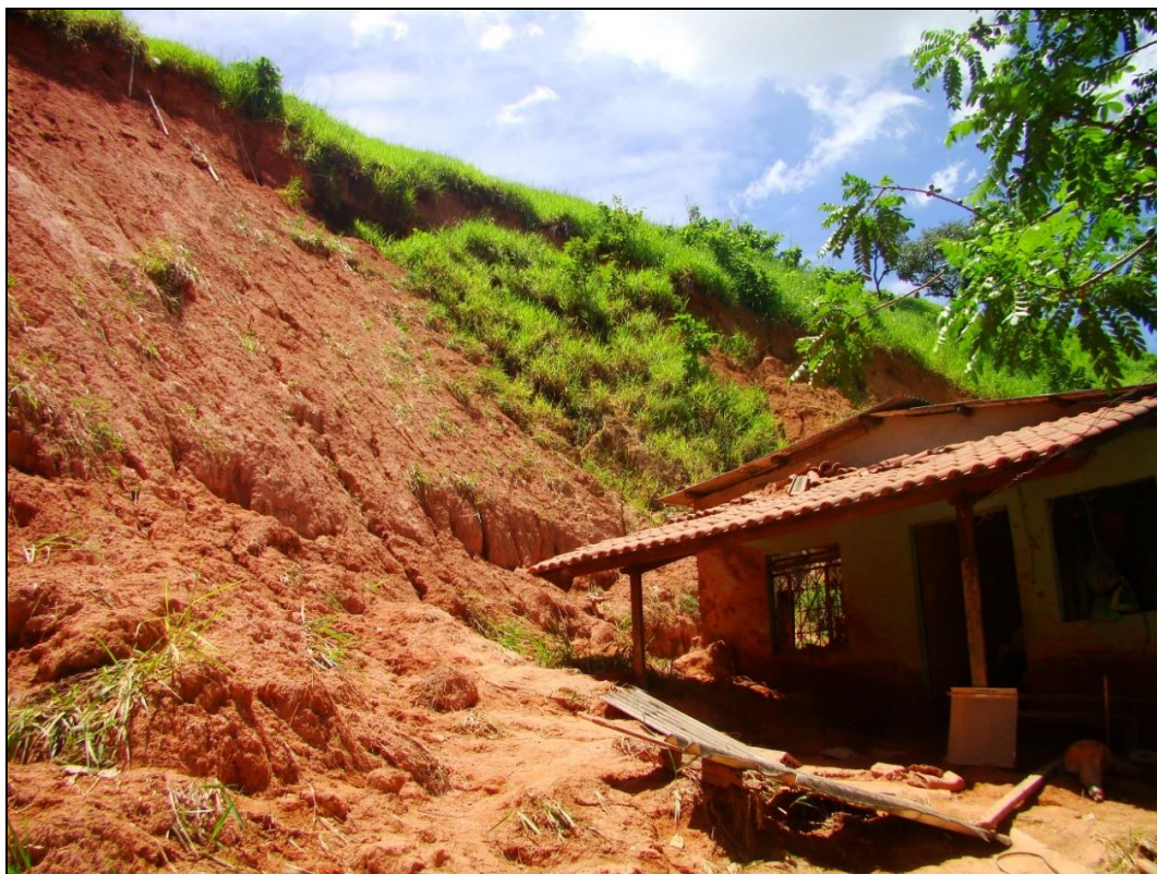
Figura 3. Deslizamento planar em Timóteo – MG.
