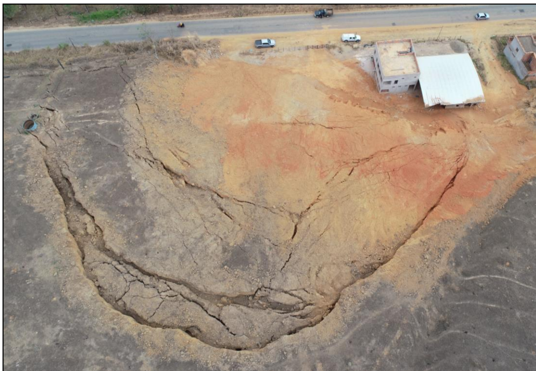
Figura 4. Deslizamento rotacional em Itabirinha – MG. Fotografia: Júlio César Lana.
