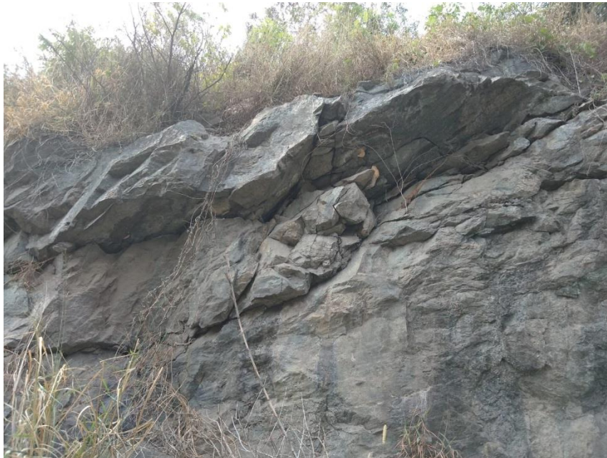
Figura 10 – Cunha entre os planos formados pela interseção de F2 e F4 no T2.
