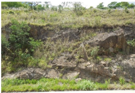
Figura 1 – Vista do talude rochoso 1 (T1).
