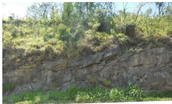
Figura 2 – Vista do talude rochoso 2 (T2).
