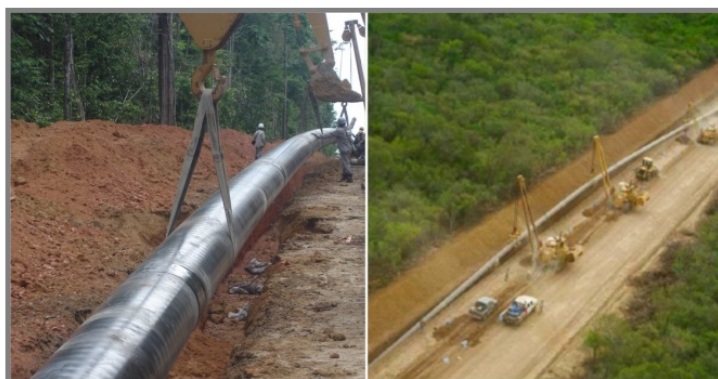
Figura 2. Construção do Gasoduto Coari-Manaus. Fonte: A autora.
