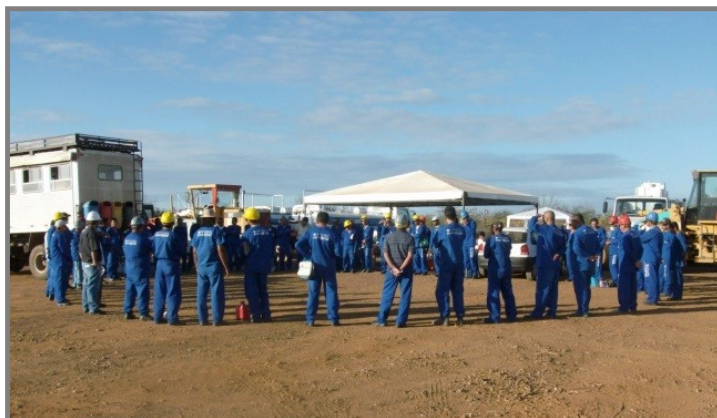
Figura 4. Gestão participativa no canteiro de obras. Fonte: A autora.
