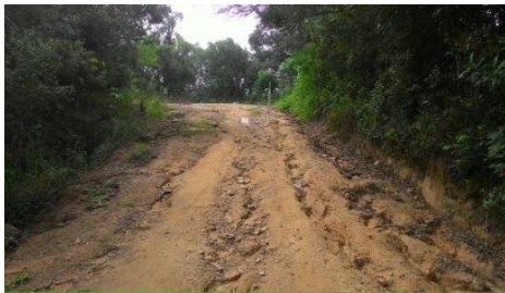
A) Incisões de sulcos no trecho inicial da estrada
