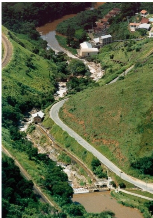
Figura 2. Usina Marmelos Zero. Vista aérea do reservatório para jusante com a BR-040 à direita (CBDB, 2011).
