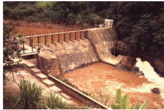
Figura 4. Usina Marmelos Zero. Detalhe do barramento vertente. Fonte: CBDB (2011).
