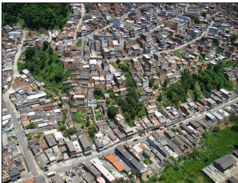
Figura 1. Exemplo de assentamento urbano precário. Fonte: IPT.
