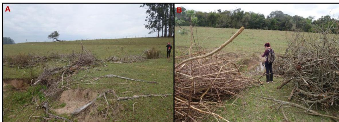
Figura 10. A) Barreira de galhos aplicada em uma das ramificações da principal feição erosiva da sub-bacia. b) Detalhe das dimensões e condições da barreira de galhos.
