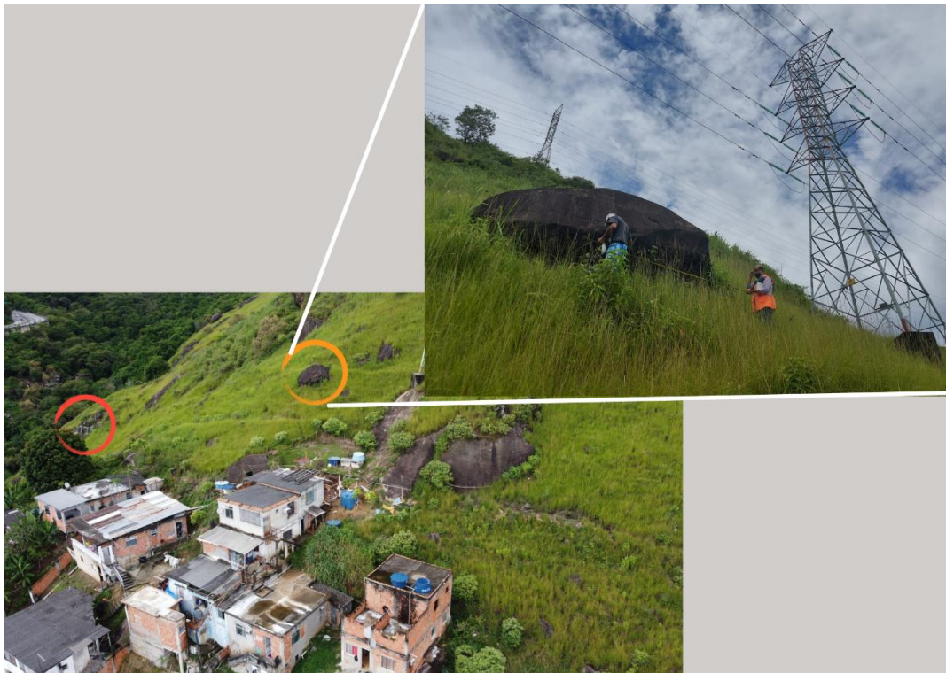
Figura 2- Imagem do drone da vertente sul. No círculo vermelho a contenção existente observada e no laranja, um bloco a ser estabilizado. Em destaque, bloco de rocha sendo caracterizado em campo para posterior projeto de estabilização.
