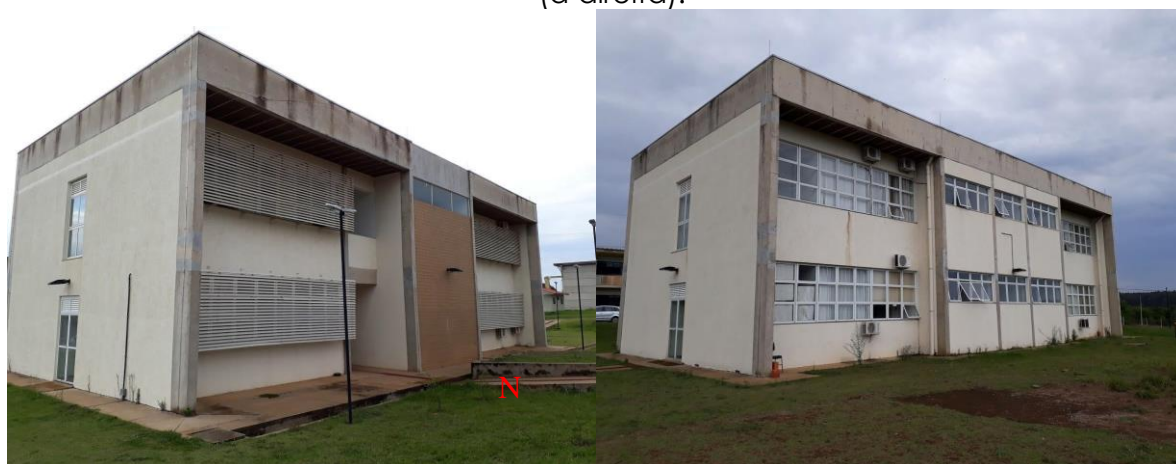
Figura 3 – Vista externa da edificação na direção nordeste (à esquerda) e sudoeste (à direita).
