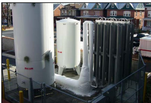
Figura 6 – Vaporizador atmosférico hospitalar em tempos normais de demanda
