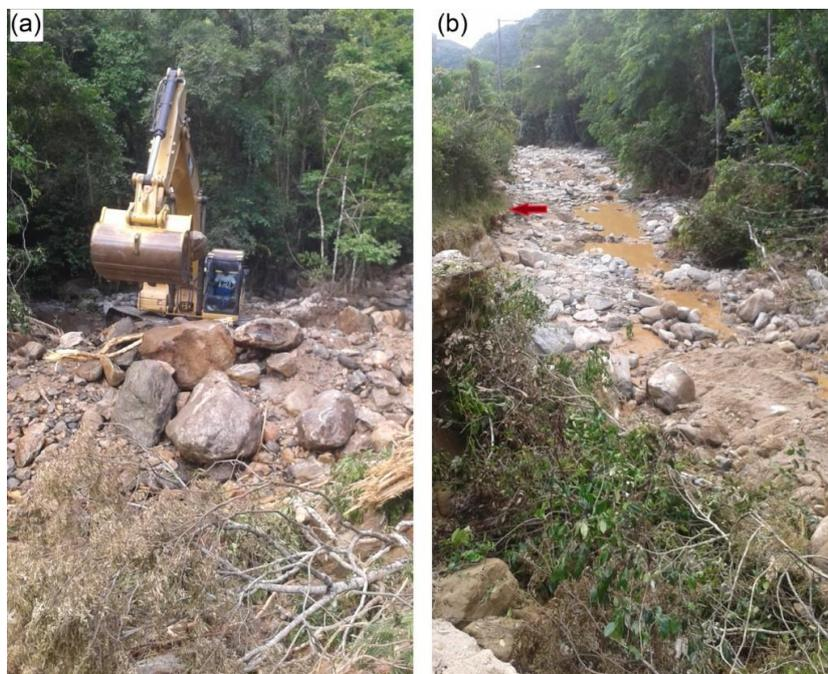
Figura 5 – (a): Curva do Rio Paúba onde o material mobilizado pela corrida de detritos rompeu o leito e invadiu a Rua Belo Horizonte. (b): Início do depósito da corrida de detritos logo após o rompimento do leito do rio, sendo possível ver as árvores derrubadas no processo e a erosão do nível da rua (seta vermelha).
