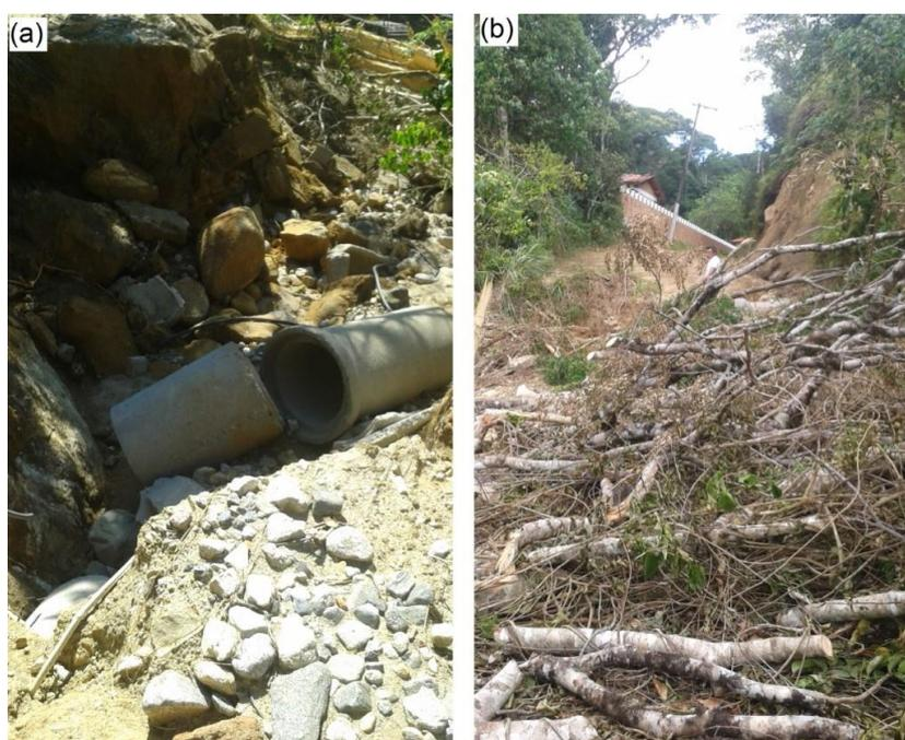
Figura 8 – (a): Rede de esgoto danificada. (b): Bloqueio da Rua Belo Horizonte invadida pela corrida de detritos, derrubando as árvores do local.
