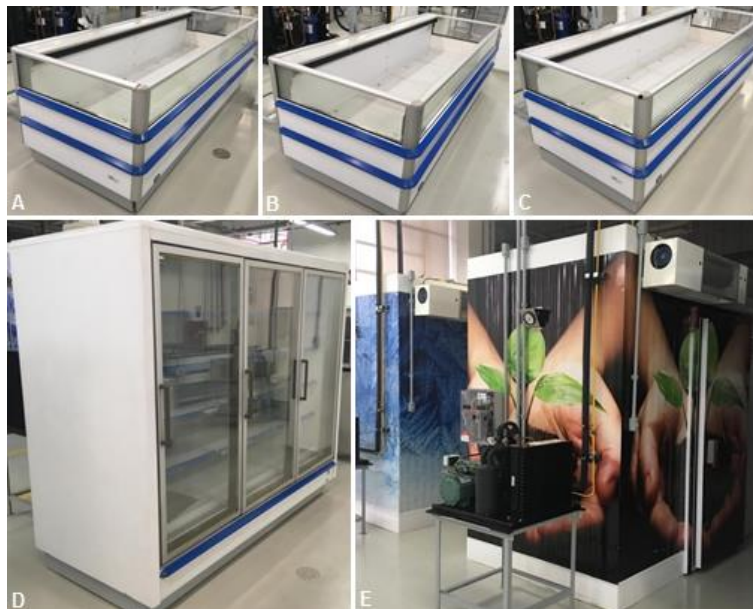
Figura 8 – Unidades internas do sistema de refrigeração de congelados – (A), (B), (C) Ilhas de congelados; (D) Expositor vertical de congelados; (E) Câmara frigorífica de congelados
