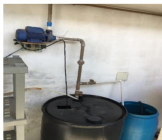
Figura 5: Sistema de Circulação de A.C.
